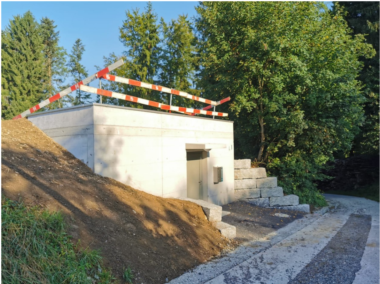
Foto: Stufen-Pumpwerk Ballwil-Sins Winterhalden, Sins (ts)
