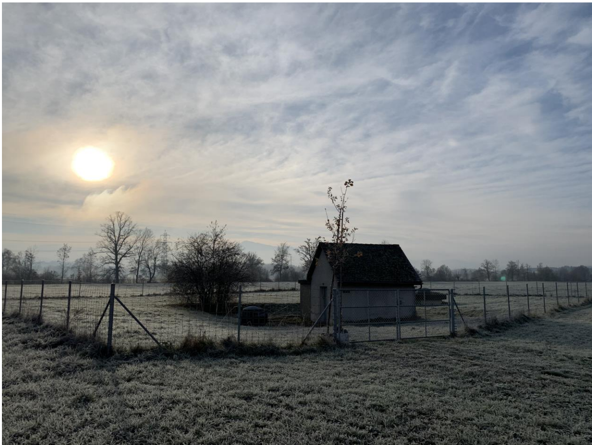
Foto: Grundwasserpumpwerk Stadtmatt, Sins (ur)
